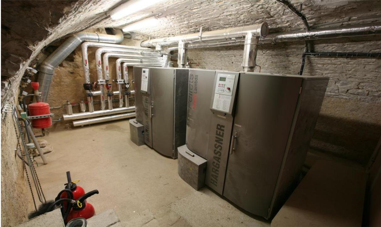
Deux chaudières Hargassner de 42 kw, couplées, produisent en alternance ou ensemble l'énergie nécessaire. Cette configuration est une sécurité en cas de panne d'une des deux machines, elle facilite la maintenance et assure la longévité des chaudières en évitant la marche à plein régime prolongé.
