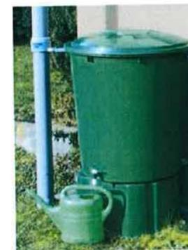
Ci-dessus : cuve de stockage connectée à une descente d'eau pluviale (source : Réalités environnement)
