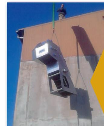
A la **station d'épuration**, le tamis dégrilleur aquaguard a été changé. Il a pour fonction l'élimination des déchets en suspension dans les eaux brutes d'entrée.
