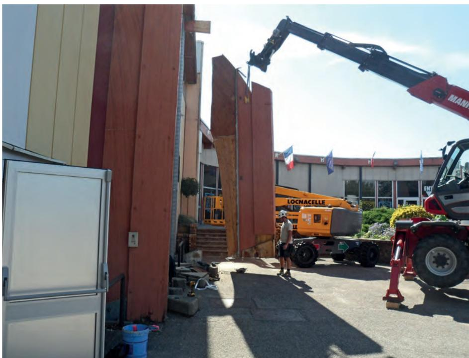
On se souvient de l'épisode qui s'est joué au Centre des Sports à l'été 2017 : à savoir le remplacement, en urgence, d'une poutre en lamellé collé de 45 m de long dont l'affaissement menaçait l'intégrité même du bâtiment. Ce chantier spectaculaire, on le sait, en annonce d'autres, puisque quatre éléments de structure de même type sont également touchés.
