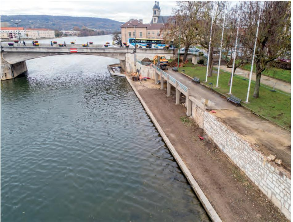
Les travaux ont été lancés début septembre par la pose des palplanches qui délimitent le passage sous le pont. Un dragage d'alluvions dans le lit de la rivière a ensuite permis de compenser, comme l'impose la Loi sur l'eau, l'apport de remblais nécessaires au chantier.
