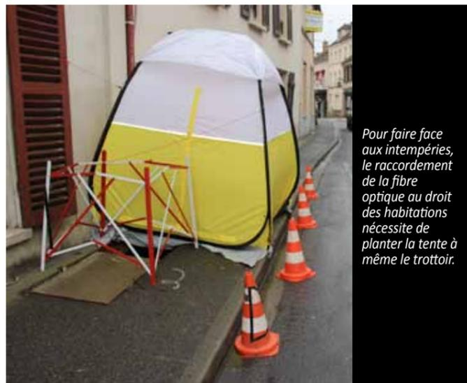
Pour faire face aux intempéries, le raccordement de la fibre optique au droit des habitations nécessite de planter la tente à même le trottoir.
