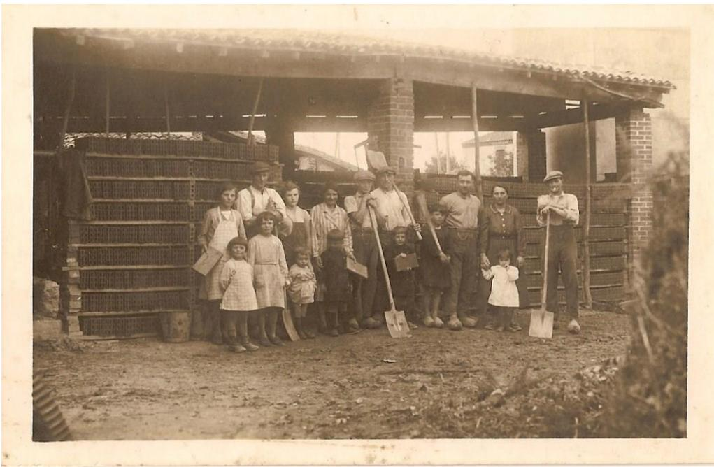
La photo a été prise en 1936 devant le séchoir. Les briques plâtrières sont posées sur des étagères. Au pignon du séchoir on aperçoit le transformateur électrique
