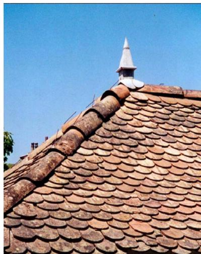
Exemple de couverture en tuiles écailles avec arêtière en tuiles creuses tenues par des tiges de fer.
