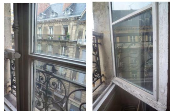
exemple de solution B): Photos d'un double vitrage avec cadre extérieur (vue face extérieure et intérieure
