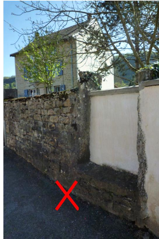
*Détail de sol en bitume venant jusqu'au pied des murs anciens, à proscrire au profit d'une bande latérale de transition par exemple en gravillons ou en stabilisé*
