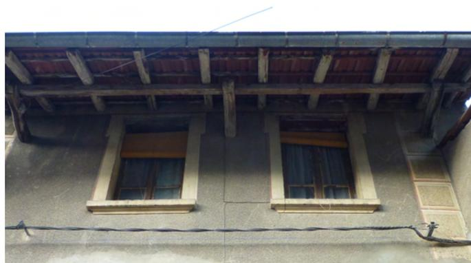
Exemples de décors de façades en enduits peints sur la commune de Vertrieu. Le décor cherche à imiter les décors en pierre: faux bossage d'angle, encadrement de baies à crossettes. Le décor produit des effets de matière par le traitement de l'enduit (enduit projeté, enduit lissé) et des effets de reliefs (chanfreins) par l'usage de la couleur. Les teintes utilisées sont à base d'ocre rouge, ocre jaune, terre de Sienne ou terre d'ombre.
