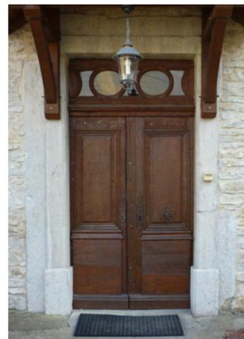
*Porte à deux vantaux style XVIIIe, à panneaux et imposte vitrée, équipée d'une très belle serrurerie en fer forgé.*
