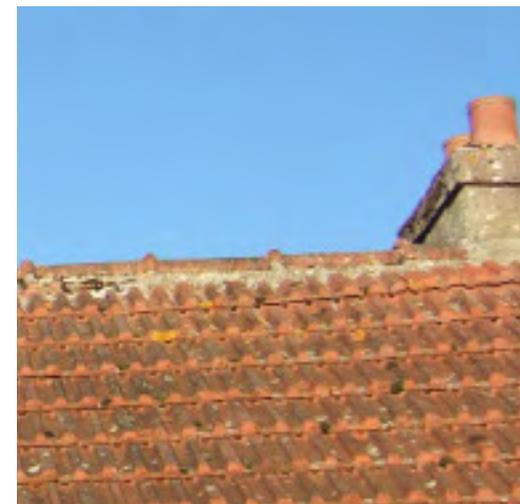
Exemple de couverture en tuiles mécaniques avec faitage en tuiles rondes scellées au mortier.
