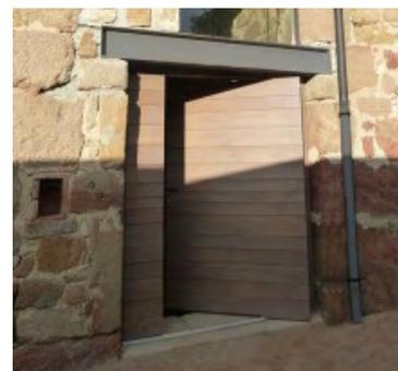
*Détail de la transformation d'une ancienne porte de grange avec un vocabulaire contemporain. linteau en métal gris, porte en bois naturel, baie vitrée à châssis invisible dans l'ancienne ouverture du comble.*
