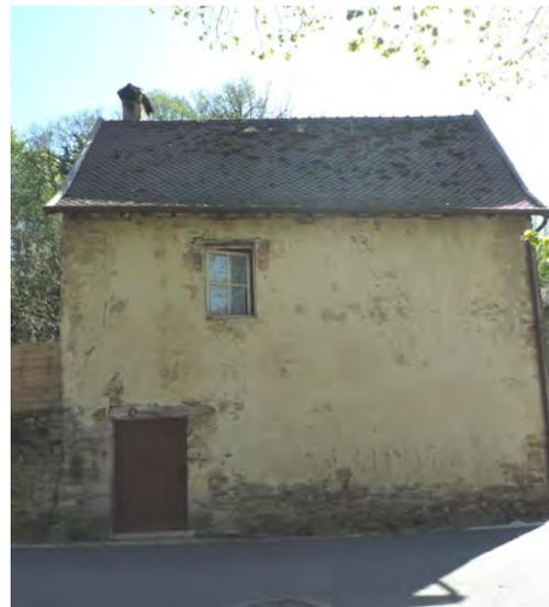
*Exemple sur la commune de parement en moellons de pierre recouvert d'un enduit de chaux*
