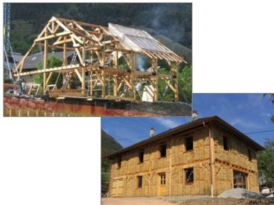
Une grosse charpente fait office de structure pour accueillir de différentes manières les ballots de paille. Le plus souvent une ossature secondaire est réalisée pour assurer le maintien des bottes.
