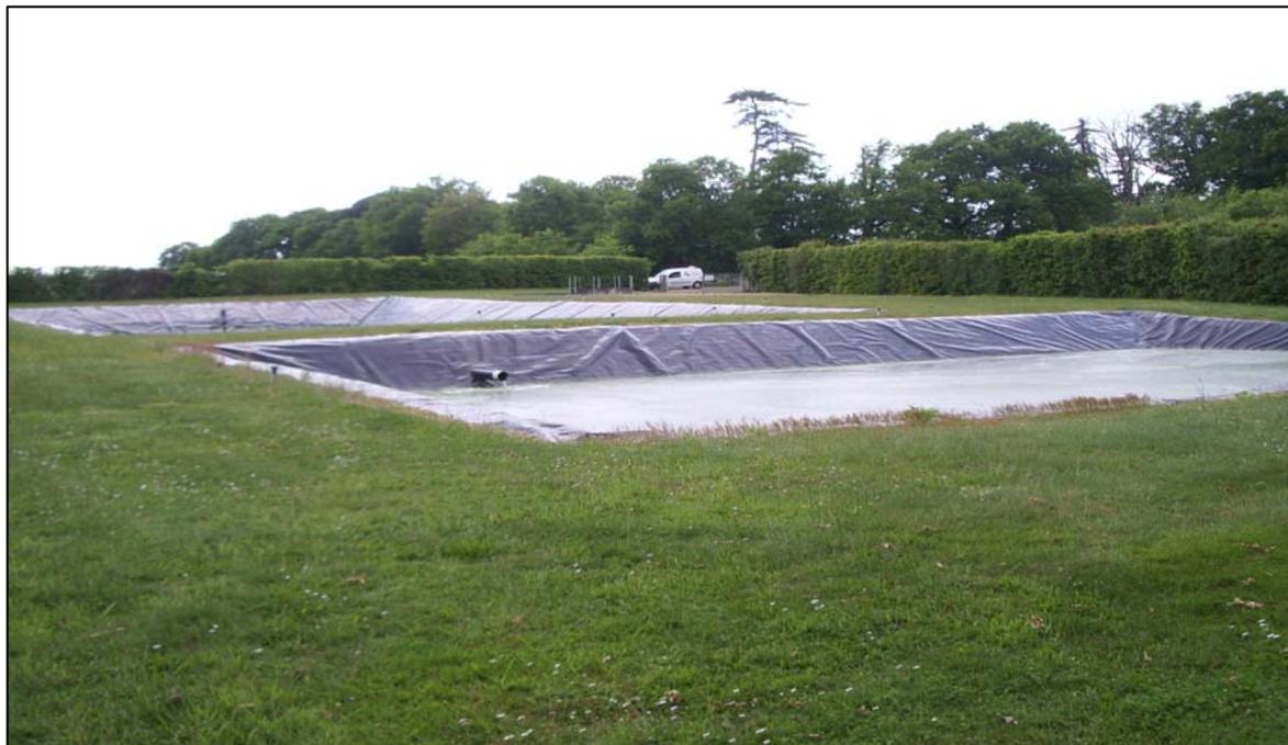
La station d'épuration de La Bénate utilise un procédé de traitement de type lagunage aéré mise en service en 1998. Sa capacité nominale théorique d'épuration est de 310 E.H., avec une surface de plan d'eau de 800 m<sup>2</sup> (590 + 210) et un volume de l'ordre de 1400 m<sup>3</sup> (Bassin aération : 1100 m<sup>3</sup>, Bassin de décantation 300 m<sup>3</sup>).
