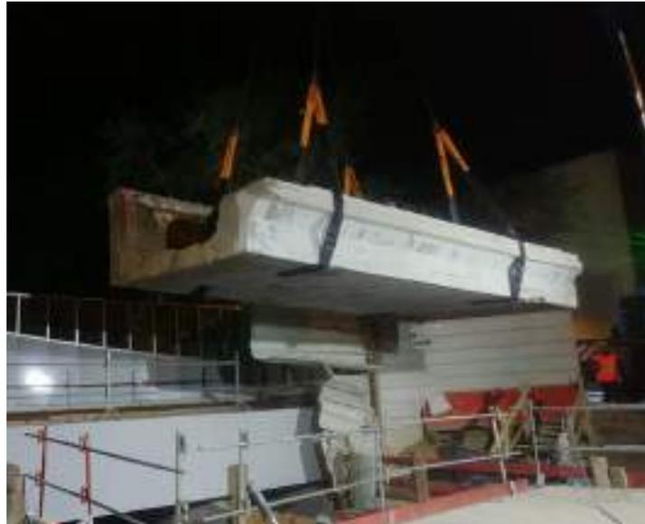
Figure 4 : Exemple d'évacuation par grutage avec passage des élingues dans le tablier - Source GINGER CEBTP
