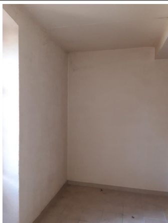
Prélèvement - P3 : Rez de Chaussée / Pièce 1 - Enduit projeté- (Absence d'amiante)
