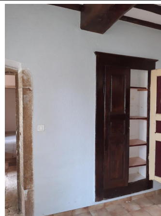
Prélèvement - P4 : Rez de Chaussée / Pièce 2 - Enduit projeté- (Absence d'amiante)
