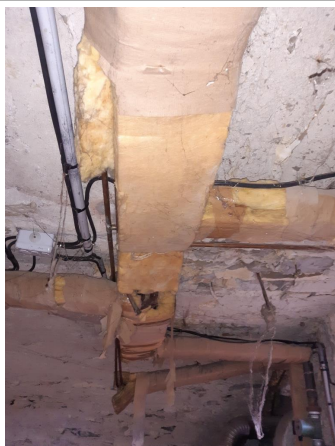
Prélèvement - P1 : Sous Sol / Palier - Calorifugeage- (Absence d'amiante)
