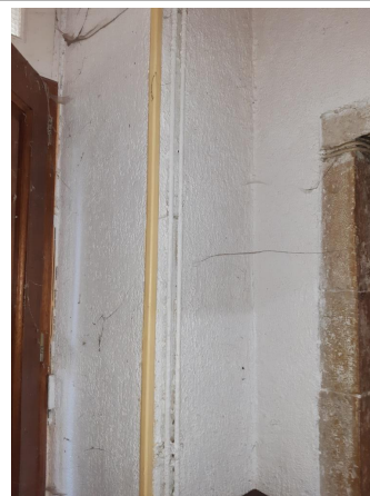
Prélèvement - P2 : Rez de Chaussée / Entrée - Enduit projeté- (Absence d'amiante)
