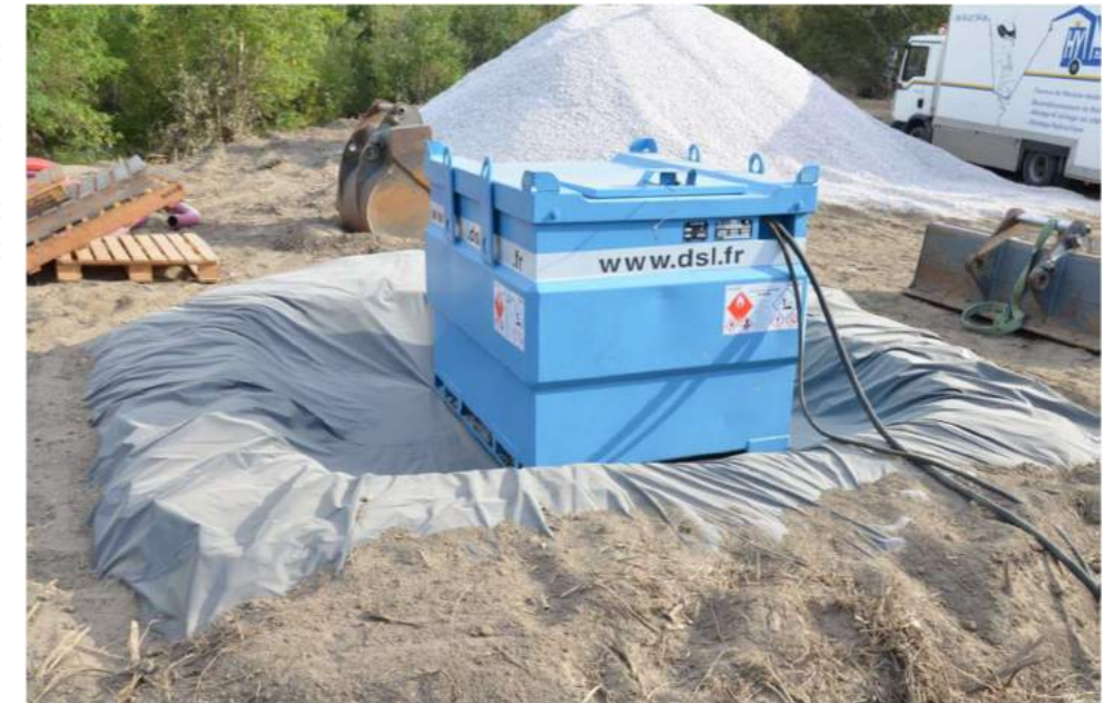
☞ Photographie 33 : Mise en place d'une rétention étanche autour d'un groupe électrogène
