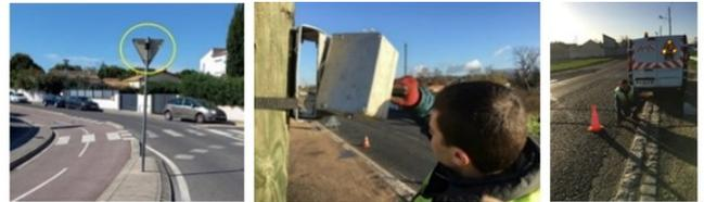
A gauche : compteurs automatiques utilisés pour cette étude modes actifs (plus précis pour ces modes) Au centre et à droite : comptages routiers traditionnels basés sur la déformation de câbles installés sur voirie
