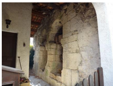
Mur du Moulin face intérieure
