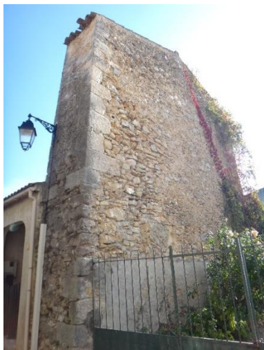
Mur du Moulin face extérieure
