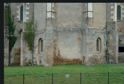
Contreforts et arcs-boutants de la nef
