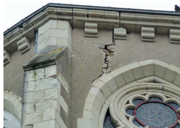
Façade sud : Sous dimensionnement des contreforts, fissuration verticale. En prévention un chaînage périphérique a été réalisé lors des précédents mandats.
