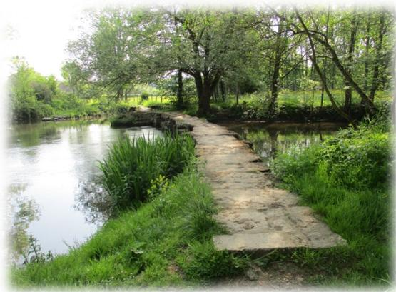
**Une passerelle de 50 mètres en dalles calcaires de 2 à 3m de long sur 1,5m de large.**
