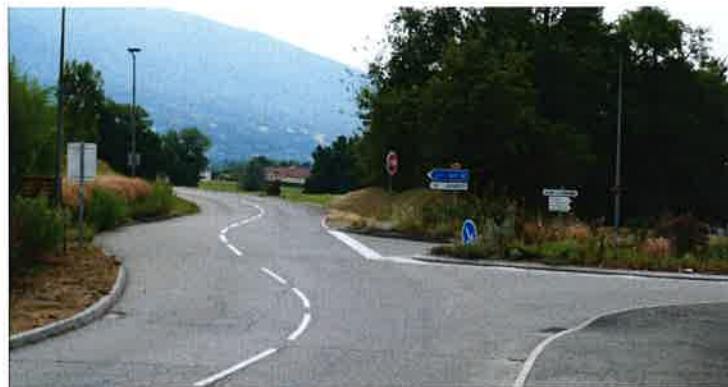
TRAVAUX À VENIR : sécurisation du carrefour route des Eparis et route de Sciondaz
