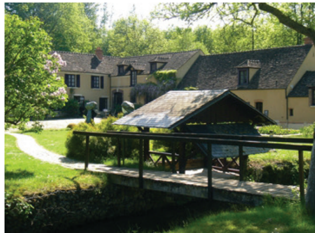
Moulin de Villeneuve - Source : commune
