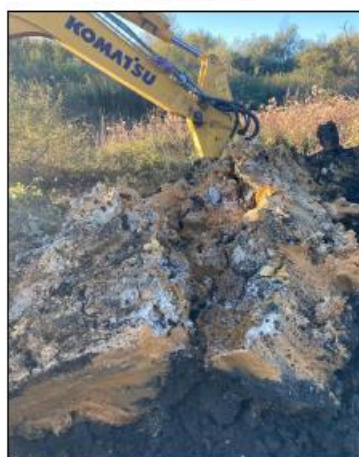
Fouilles dans le cadre de l'étude géotechnique ingésoil
