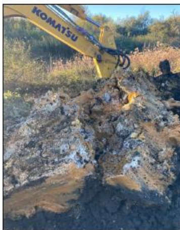
Fouilles dans le cadre de l'étude géotechnique ingésol
