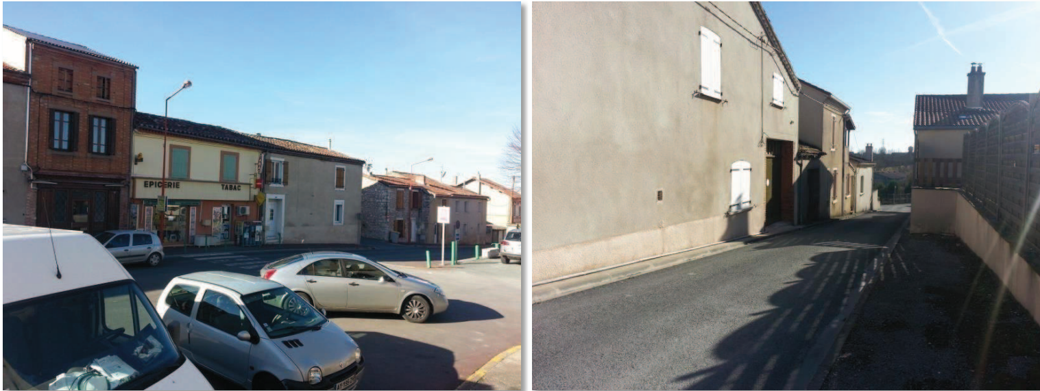
Ilots composés de maisons de ville souvent en R+1, avec quelques R+2, aux ruelles étroites – Village de Blaye-les-Mines
