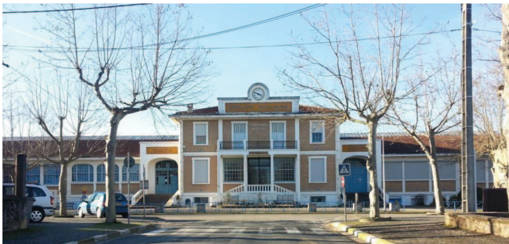
Ecole Fontgrande, bâtiment remarquable de la cité ouvrière – Saint-Benoit-de-Carmaux
