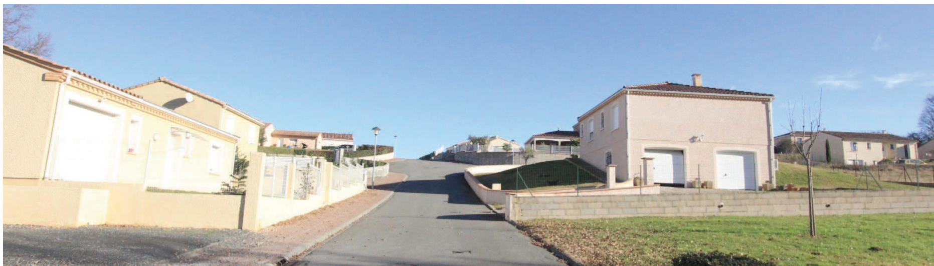
Vue d'un quartier très récent issu d'une opération d'ensemble. En position éloigné du centre ville, en limite de zone agricole, ce quartier des Cantaires à Blaye-les-Mines prend place sur un relief dominant le ruisseau du Candou. Sa position en coteau et en crête le rend très visible, le côté très homogène de ces édifices, n'ayant plus les caractéristiques architecturales locales, nuit au paysage de ce type quartier, trop fréquent de nos jours. Bâtisses au milieu de la parcelle, maisons « méditerranéennes », gestion aléatoire des pentes... représentent plusieurs inconvénients récurrents.
