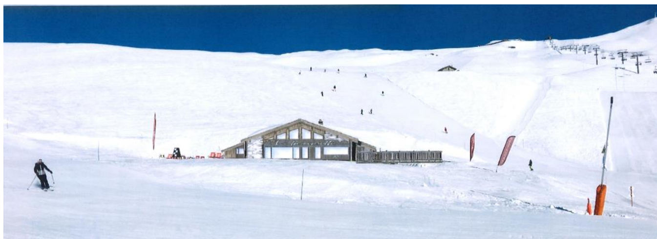
INSERTION POSSIBLE DANS LE PAYSAGE PROCHE DU RESTAURANT APRÈS RÉALISATION DE GARAGE ET EXTENSION DE LA TERRASSE
