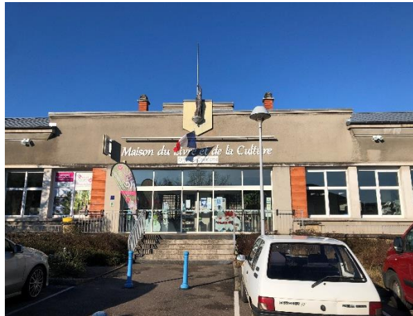
Rue de la Porte de la Moselle
