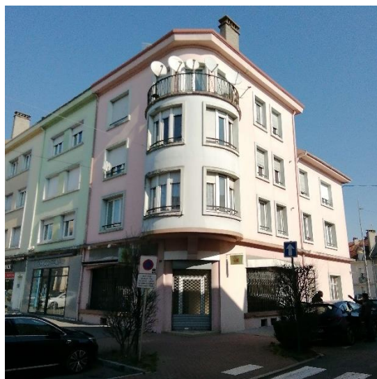
12° Angle rue Maurice Barrès / rue des Halles (côté pair)
