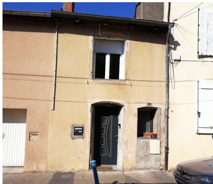
15 Rue de la République – 4 logements recensés vacants et dégradés
