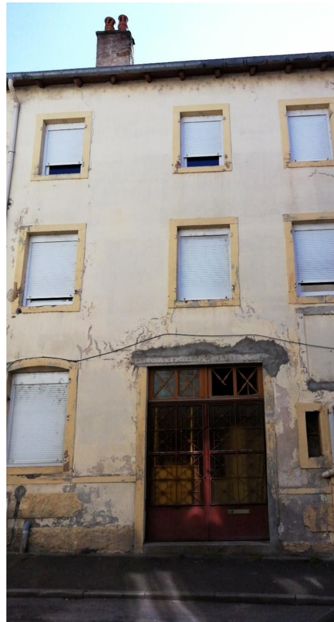
2 rue du 11 Novembre 1918 – Bâti très dégradé et vacant
