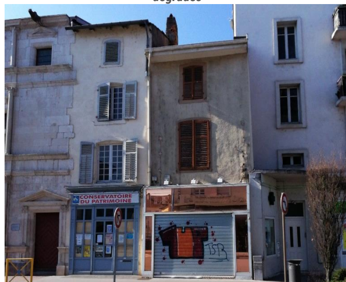
17 Rue Maurice Barres – Bâti dégradé, sans accès indépendant aux étages supérieurs
