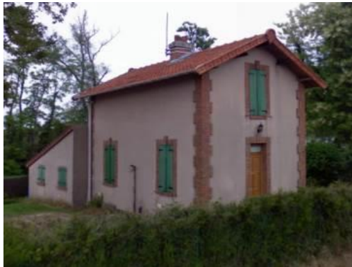
L'ancienne gare de la ligne Paris- Chartres
