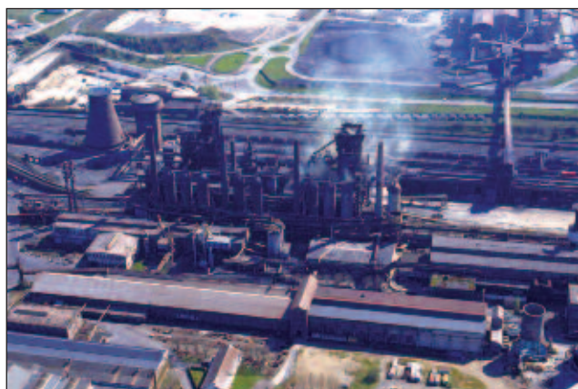
Usine de Rombas : vue aérienne des deux hauts fourneaux fonctionnant à partir du minerai lorrain dopé par injonction de minerais d'importation plus riche
