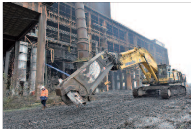
Hiver 2021 : déconstruction en cours de l'aciérie de Gandrange. Peut-être au profit de l'implantation d'une filière hydrogène verte ? (Photographie Jean-Louis PIRONIO)
