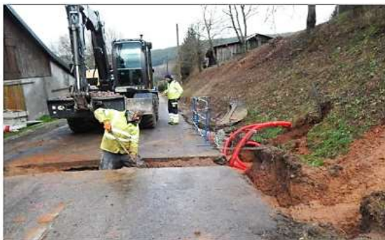
Cette 5 e tranche de travaux concerne l'enfouissement des réseaux secs.
