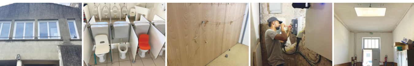
MAISON DES ASSOCIATIONS Remplacement de quatre fenêtres
