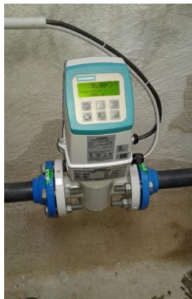
Débitmètre sortie surpressée
