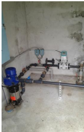
Débitmètre sortie surpressée
