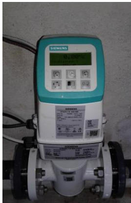
Débitmètre sortie surpressée
