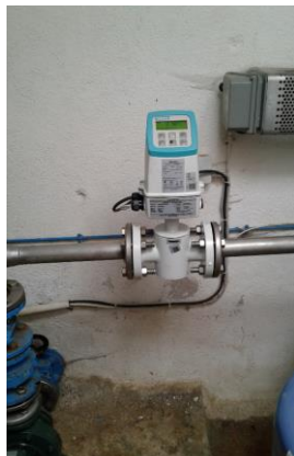
Débitmètre sortie Relais Montcarbon
