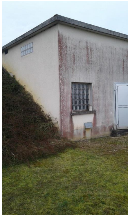
Figure 21 : Vue extérieure du réservoir
