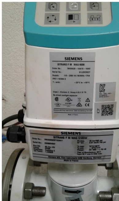
Figure 55 : Débitmètre sortie relais Montcorbon
