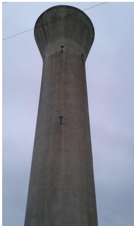
Figure 14 : Réservoir sur tour de Douchy
