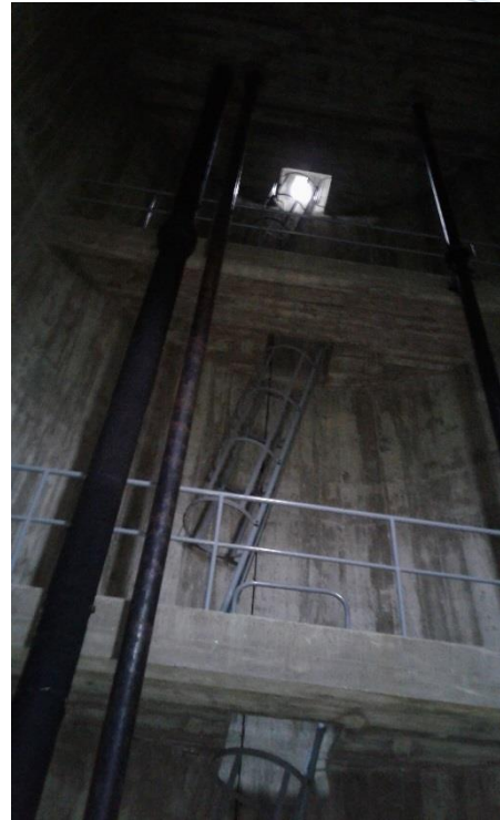
Figure 23 : Vue intérieure du réservoir sur tour de Douchy
