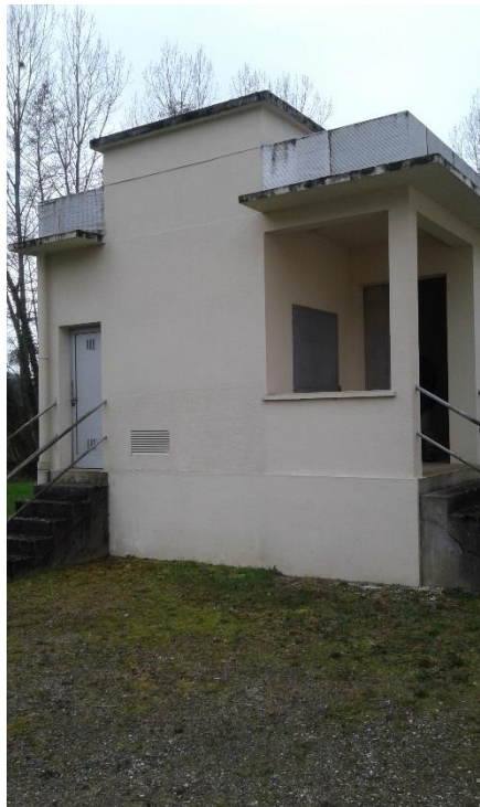
Figure 6 : Captage de la Métairie
