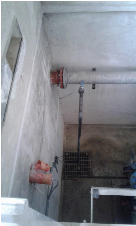
Figure 19 : Vue intérieure du réservoir
