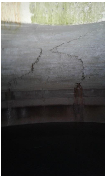
Figure 22 : Dôme fissuré
