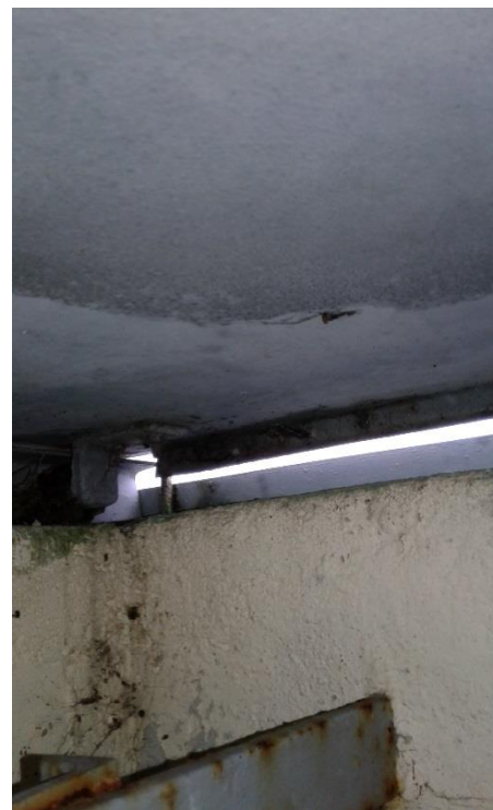
Figure 25 : Trappe d'accès au toit
