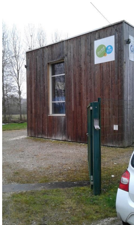
Figure 8 : Vue extérieure de la station
