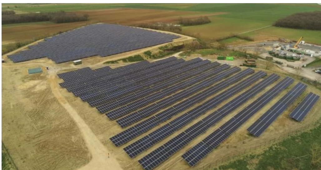
Parc photovoltaïque réalisé par Sergies à Méssemé près de Loudun
