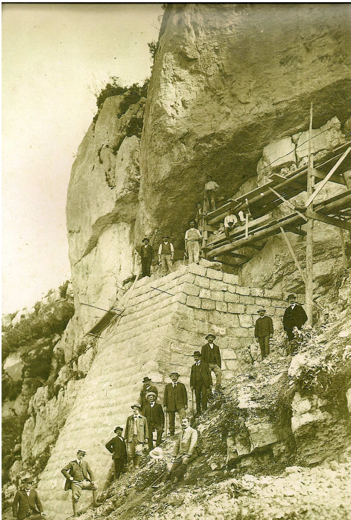
L'édification du mur de soutènement de la masse centrale du rocher. Les ouvriers de l'entreprise Bernasconi reçoivent la visite du Conseil municipal de Chignin. Septembre 1913.
