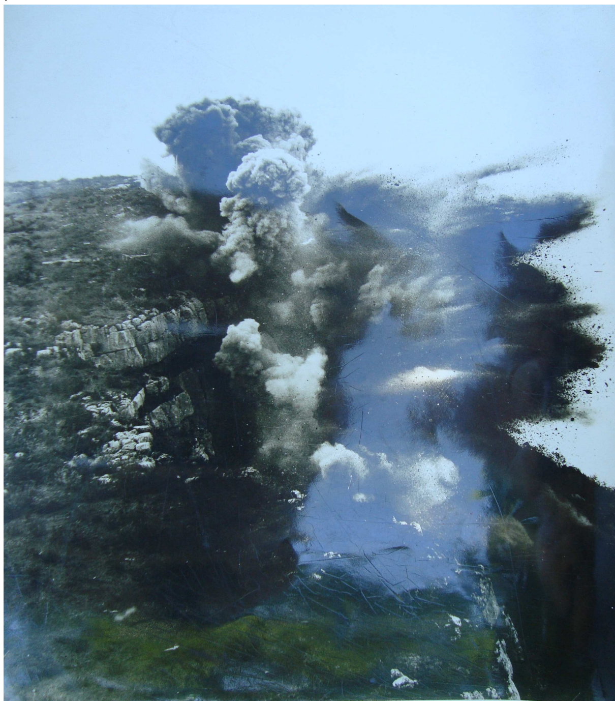
L'explosion simultanée des 260 mines. 22 mai 1913, 10h 22.
