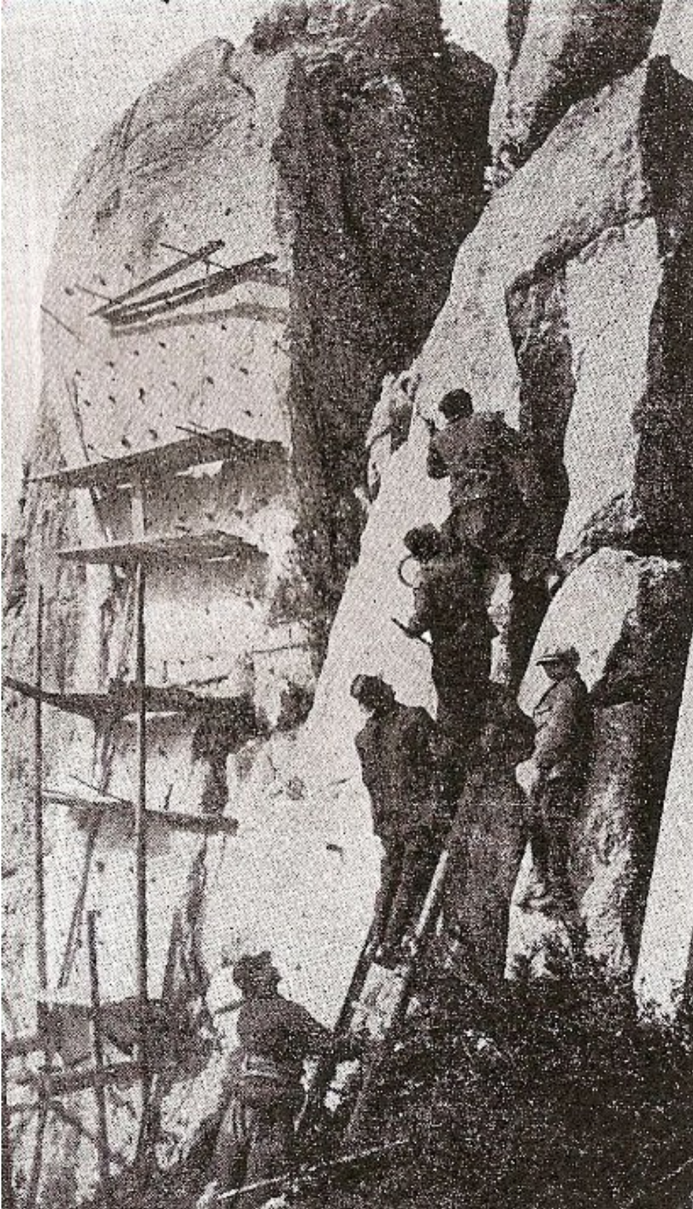
Le forage des 260 trous de mine
