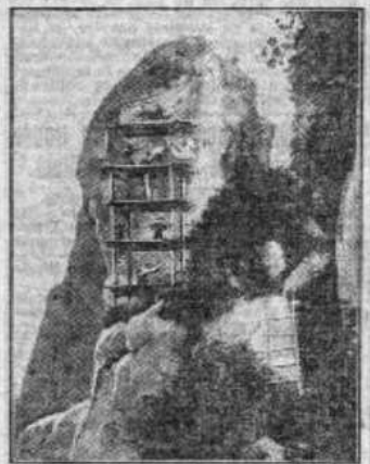
Le travail effectué dans le rocher pour y pratiquer des trous de mine
