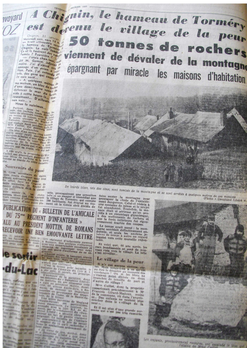
L'éboulement de Janvier 1957 à Torméry.
