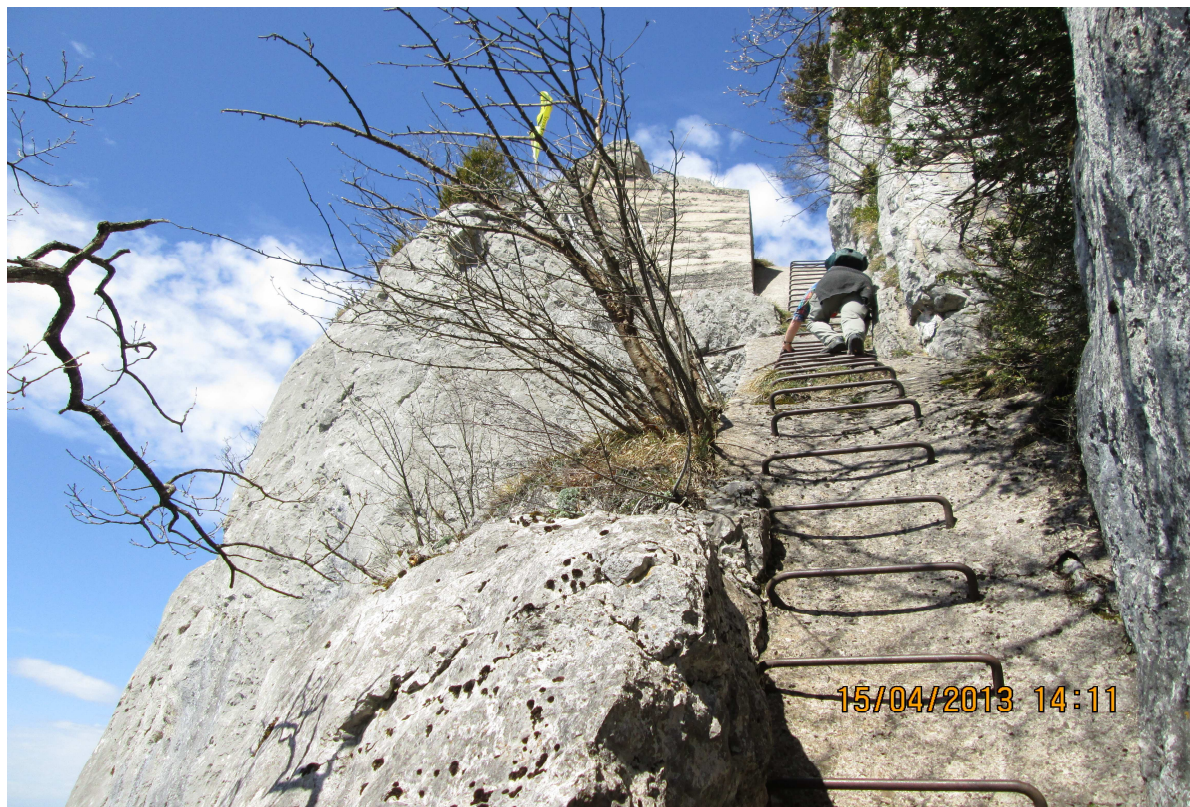
Ancrage de la partie centrale du Rocher avec du béton armé coulé dans la crevasse. Photo L. Freschi 2013
