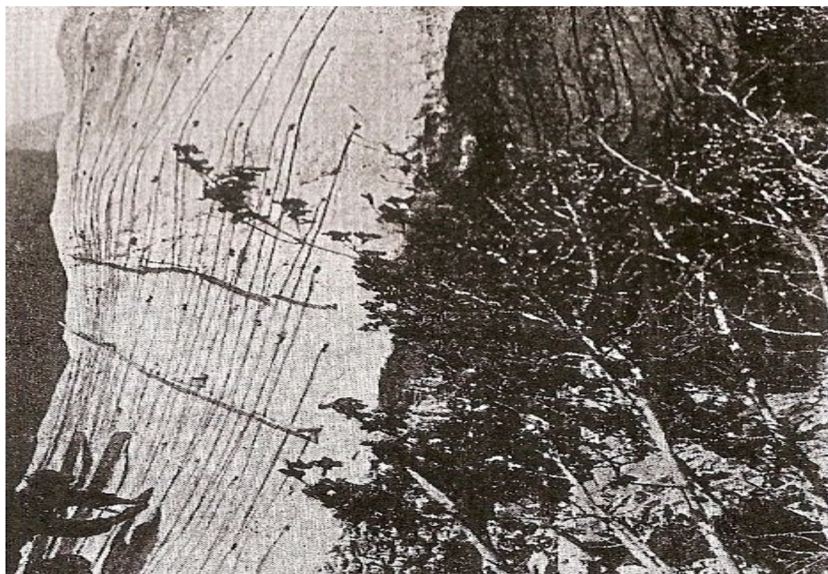
Le chargement de la dynamite et la pose des cordons détonants dans les trous de mines. L'illustration, mai 1913
