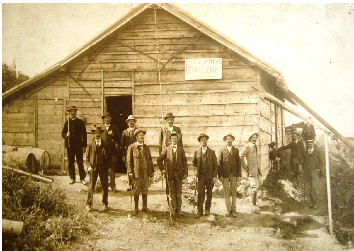
Le maire, les conseillers municipaux et l'ingénieur Reulos devant la cabane de chantier. Septembre 1913.
