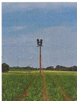
Il s'agissait d'effectuer le remplacement des isolateurs et la réalisation de quelques travaux d'élagage nécessaires le long des lignes haute tension sur les hauts de Flavy. C'était l'occasion d'apprécier les compétences (parfois acrobatiques) des intervenants et aussi de mieux connaître leur métier. Si ces opérations ont généré quelques brèves perturbations, les travaux réalisés devraient (espérons-le) limiter les coupures cet hiver...
