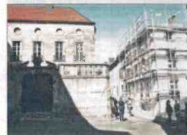
Les travaux en cours à l'angle de la rue des Royaux, et celle des Chanolmes s'inscrivent dans la même démarche.
