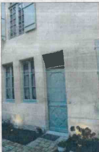
Sept logements marais ont été rénovés dans la rue des Royaux.
