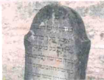
Les travaux porteront sur le mur de clôture avec nettoyage et reprise des joints à la chaux. Ils permettront aussi de restaurer et de relever les tombes. En effet, une source qui passe en dessous du cimetière perturbe les caveaux. Photo: Raphaël
