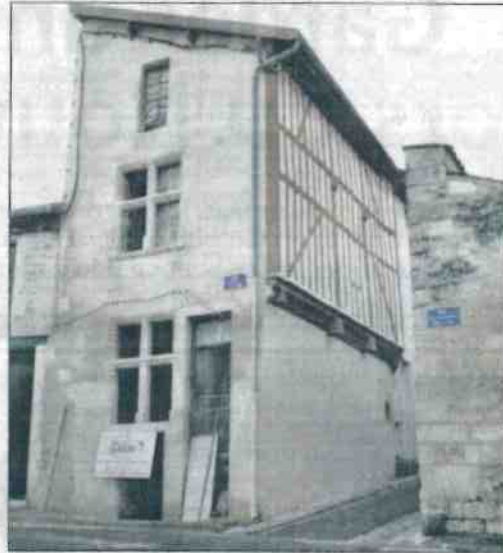
Les travaux extérieurs ne sont pas terminés mais la transformation est déjà remarquable.
