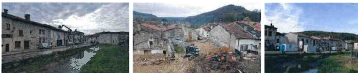
Différentes phases du chantier – Rue du Canal
