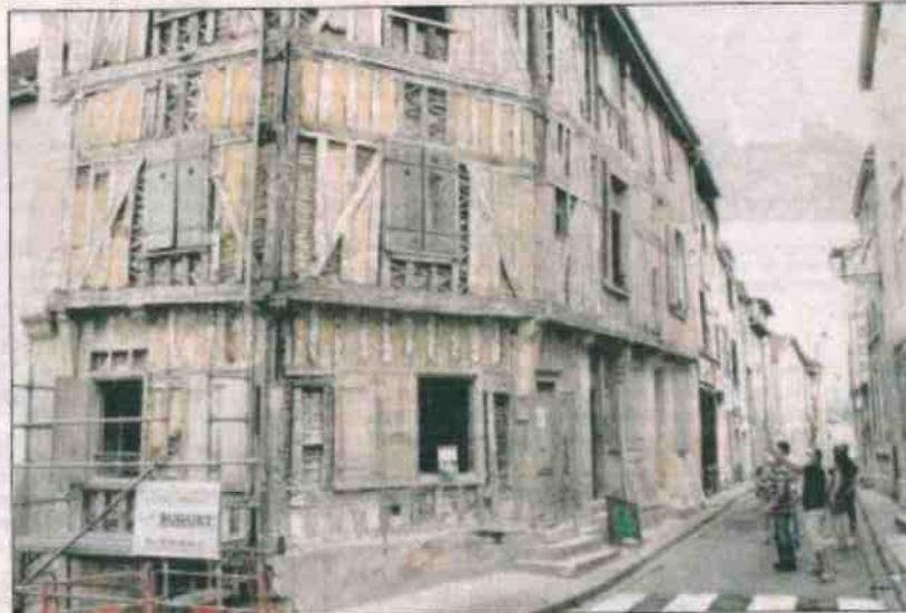
La restauration de cette maison sera une vitrine pour le savoir-faire local.
