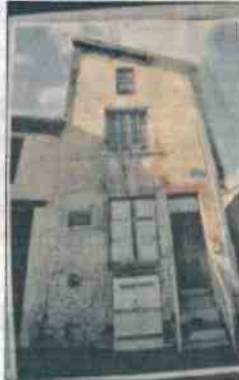
Cette maison sans confort a été habitée pendant plusieurs années.
