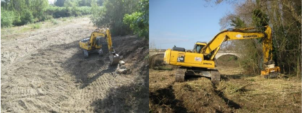
Broyage et scarification d'atterrissements
