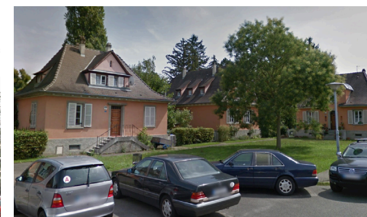
La place des accacias - cité Ungemach - Strasbourg : un arbre, un espace vert et des constructions simples : des ingrédients sans prétention qui assurent une grande qualité au cadre de vie.
