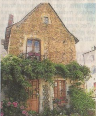
Près de l'église à Neuville, cette rénovation a mis au jour de superbes lucarnes en tuffeau, typiques du village.
