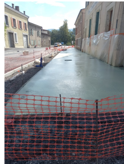
Trottoirs en béton désactivé et goudronnage
