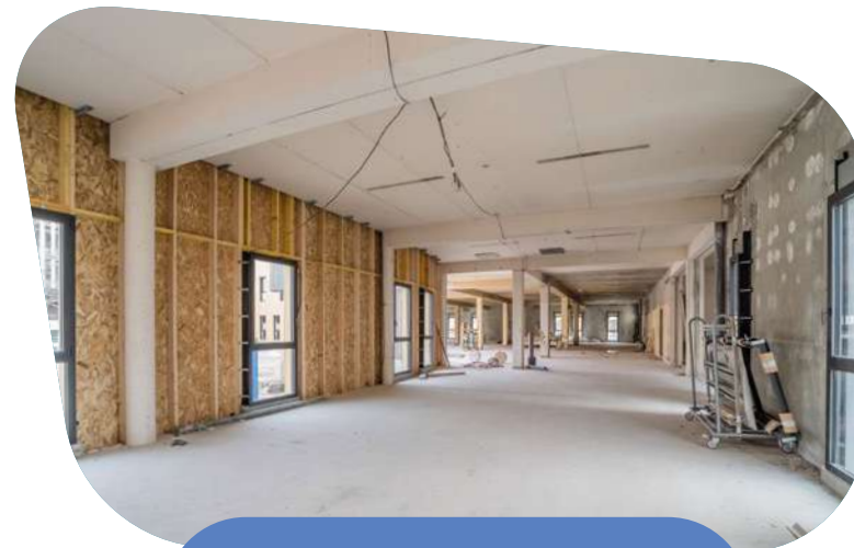
Réhabilitation du futur siège de l'Agglomération
