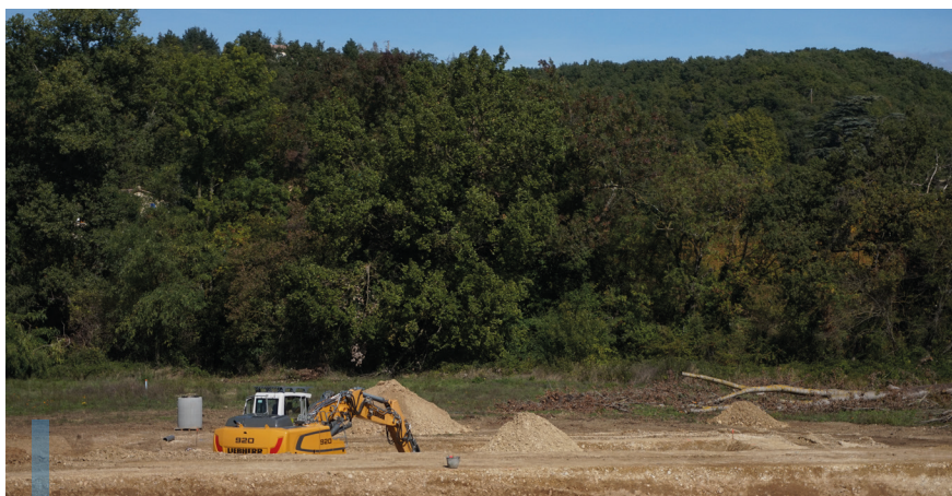
Travaux de la nouvelle station de traitement ©JM. Minaudier
