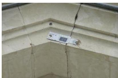
Par ailleurs, des fissuromètres ont été installés sur le clocher. Grâce à une lecture régulière de l'écartement de la fissure, ces appareils de mesure permettront de sui-
