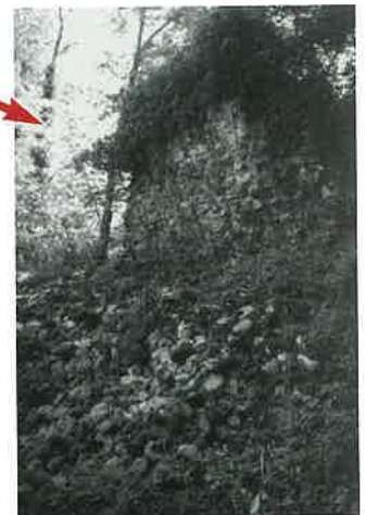
Ruines subsistant de l'ancien château.
