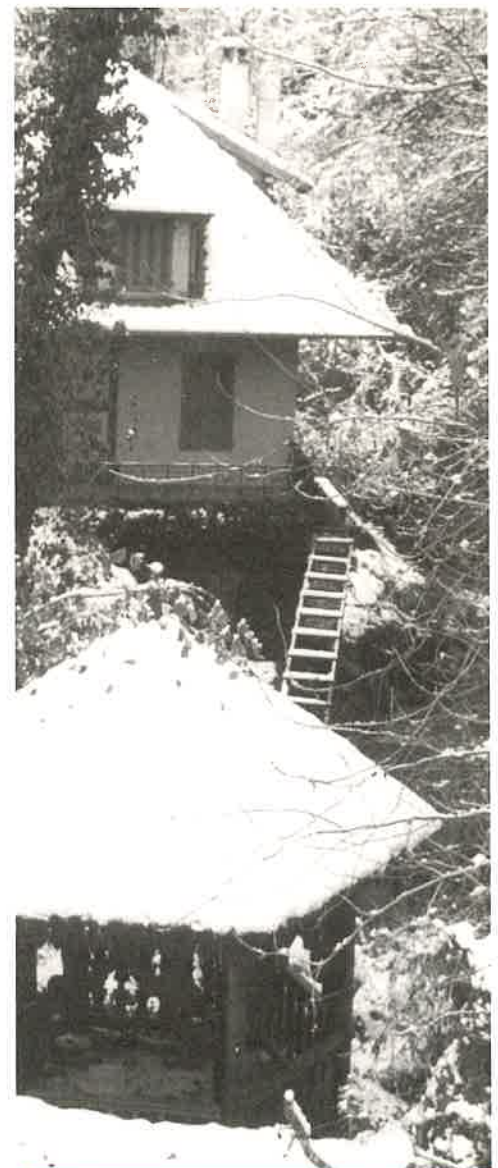
L'Ancien moulin "Plat" situé sur le Nant de Balévaz transformé en maison d'habitation.
