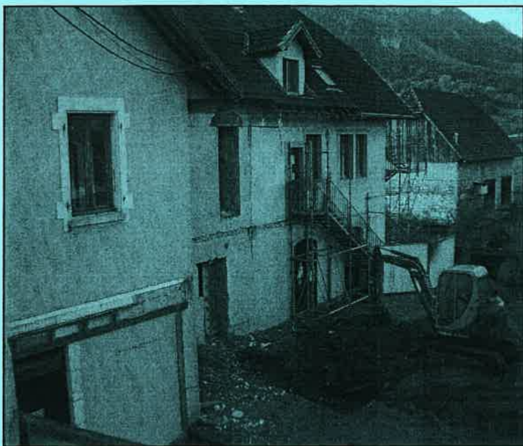
Terrassement en cours
