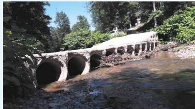
Le gué du Calois avant travaux
