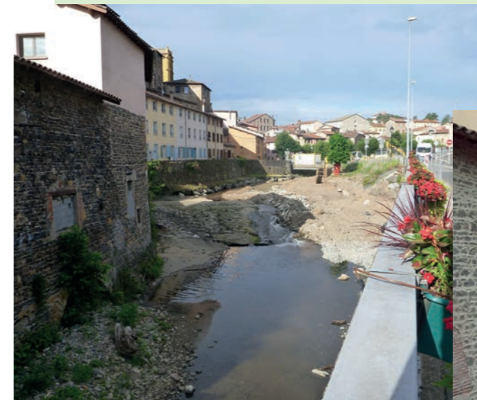
Le seuil avant travaux
