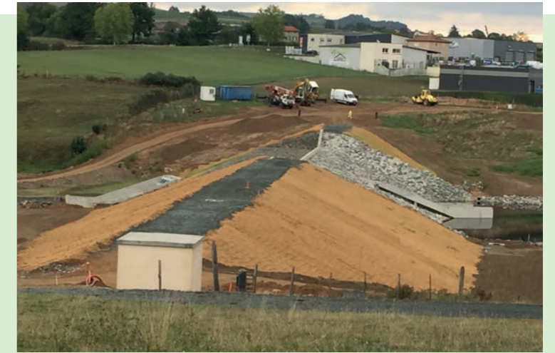
Le barrage écrêteur de crues sur la Turdine - Septembre 2017
