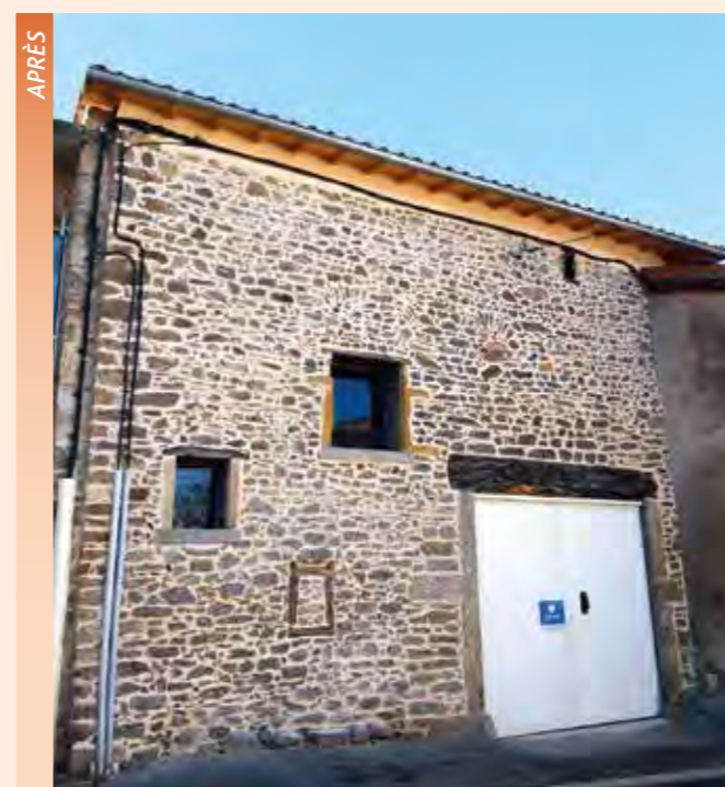
Rénovation façade de la grange à côté de la mairie
