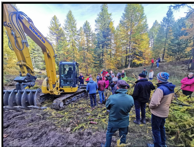
Visite du chantier de décapage avec les élus et les partenaires financiers et scientifiques (octobre 2022)
