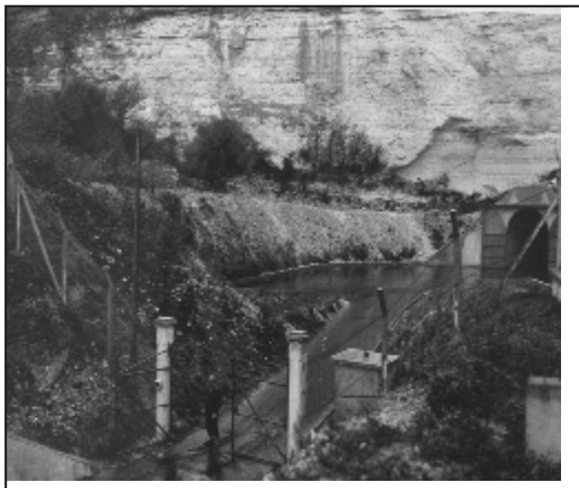
Le même site après travaux codé "Erika" le QG de remplacement de Rommel à Maniot. (Photo Truttmann)
