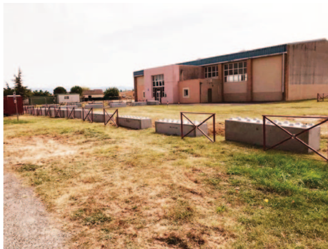
Sécurisation de la salle Suderie
