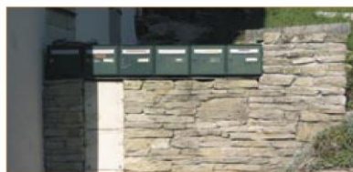
Boîtes aux lettres et coffrets de réseaux peuvent être intégrés aux murets ou à des éléments de clôture.
