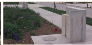
L'intégration des coffrets dans un petit muret construit à l'identique sur l'ensemble de l'opération permet d'en réduire l'impact.
