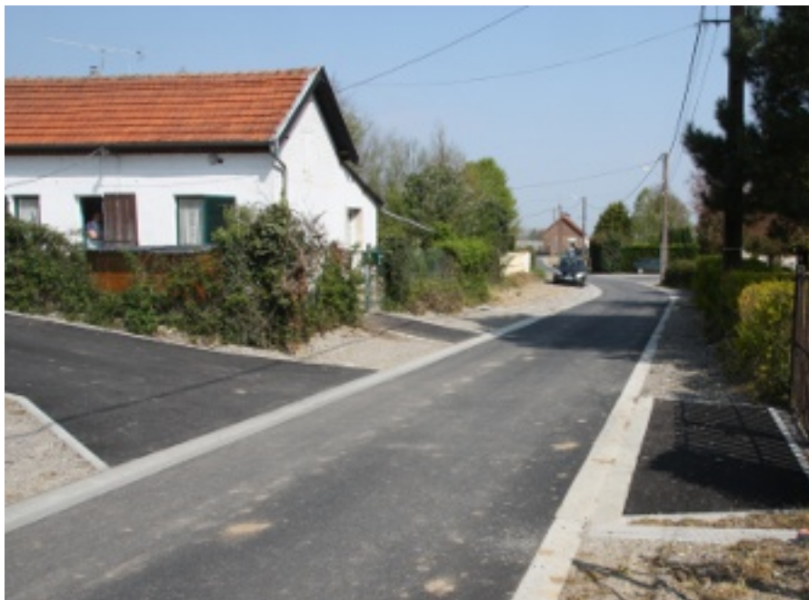
La rue de la fontaine après travaux
